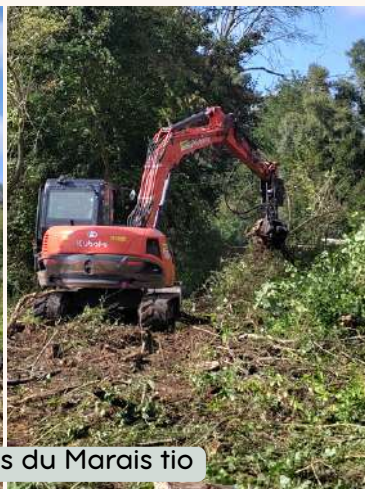
Reprofilage des fossés Digue du Pont malin
